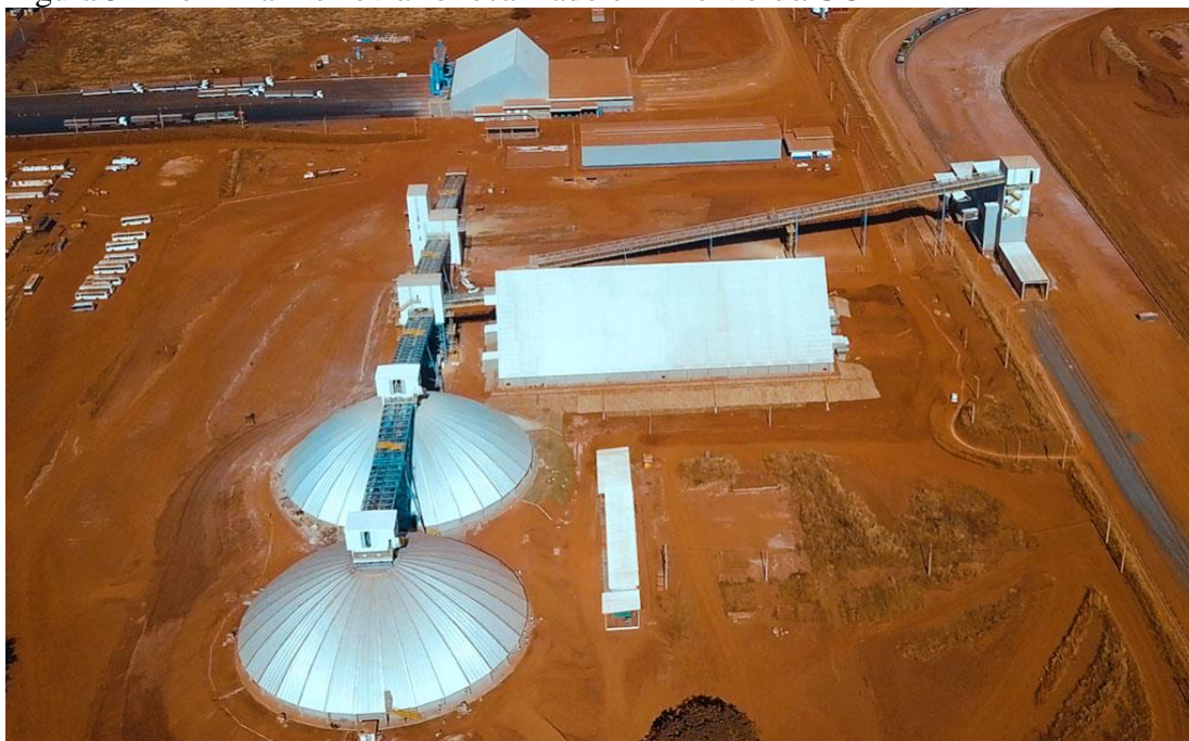
Figura 5 – Terminal Ferroviário localizado em Rio Verde/GO
