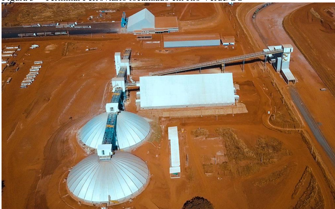
Figura 5 – Terminal Ferroviário localizado em Rio Verde/GO
